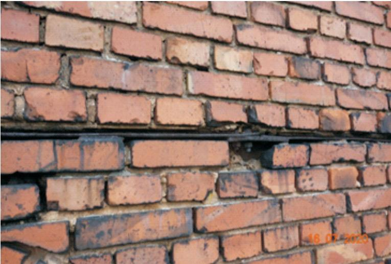
(Eingelegtes korrodiertes Eisenband)
